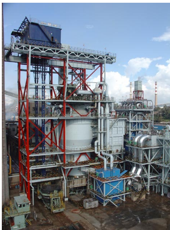
图 3-54 干法熄焦装置
