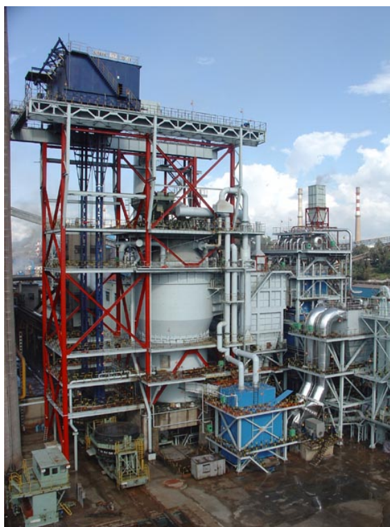
图 3-54 干法熄焦装置
