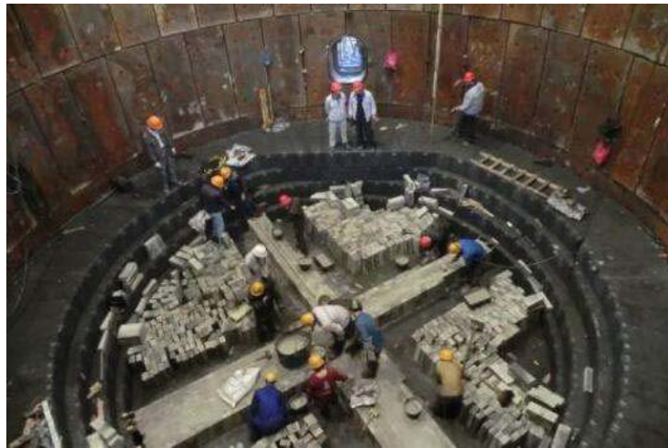
图 8.5 砌筑高炉底
