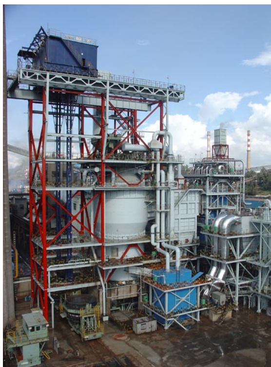
图 3-54 干法熄焦装置
